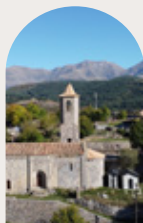
01 SANTA MARIA DE VIU DE LLEVATA EL PONT DE SUERT Pàg. 04
